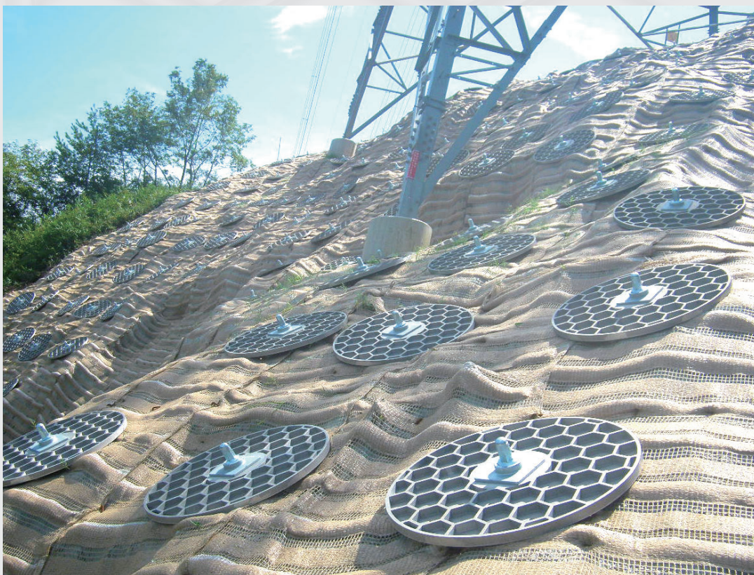
広島県竹原市 斜面補強
